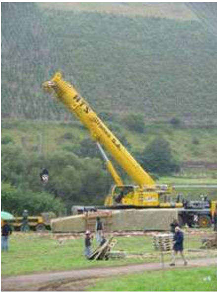
Die Kunst, 38 Tonnen von der Waagerechten in die Senkrechte zu hieven - Vorbereitungen
